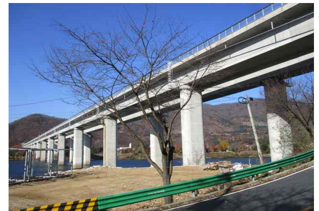
서종대교(양양) 측면 전경
