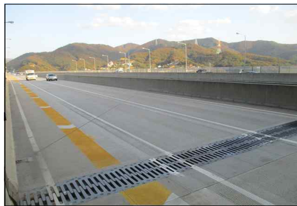
서종대교(서울) 상부 전경
